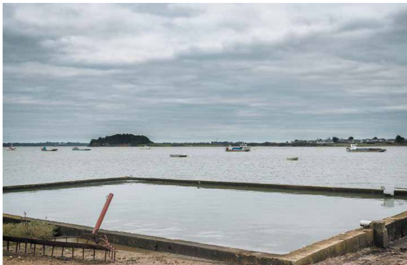
Chantier Le Joubiou, rive de Pencadenic
