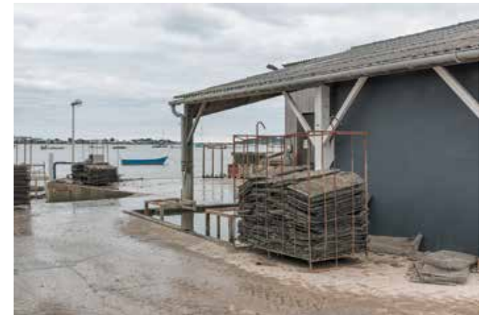
Chantier Le Joubioux, rive de Pencadenic
