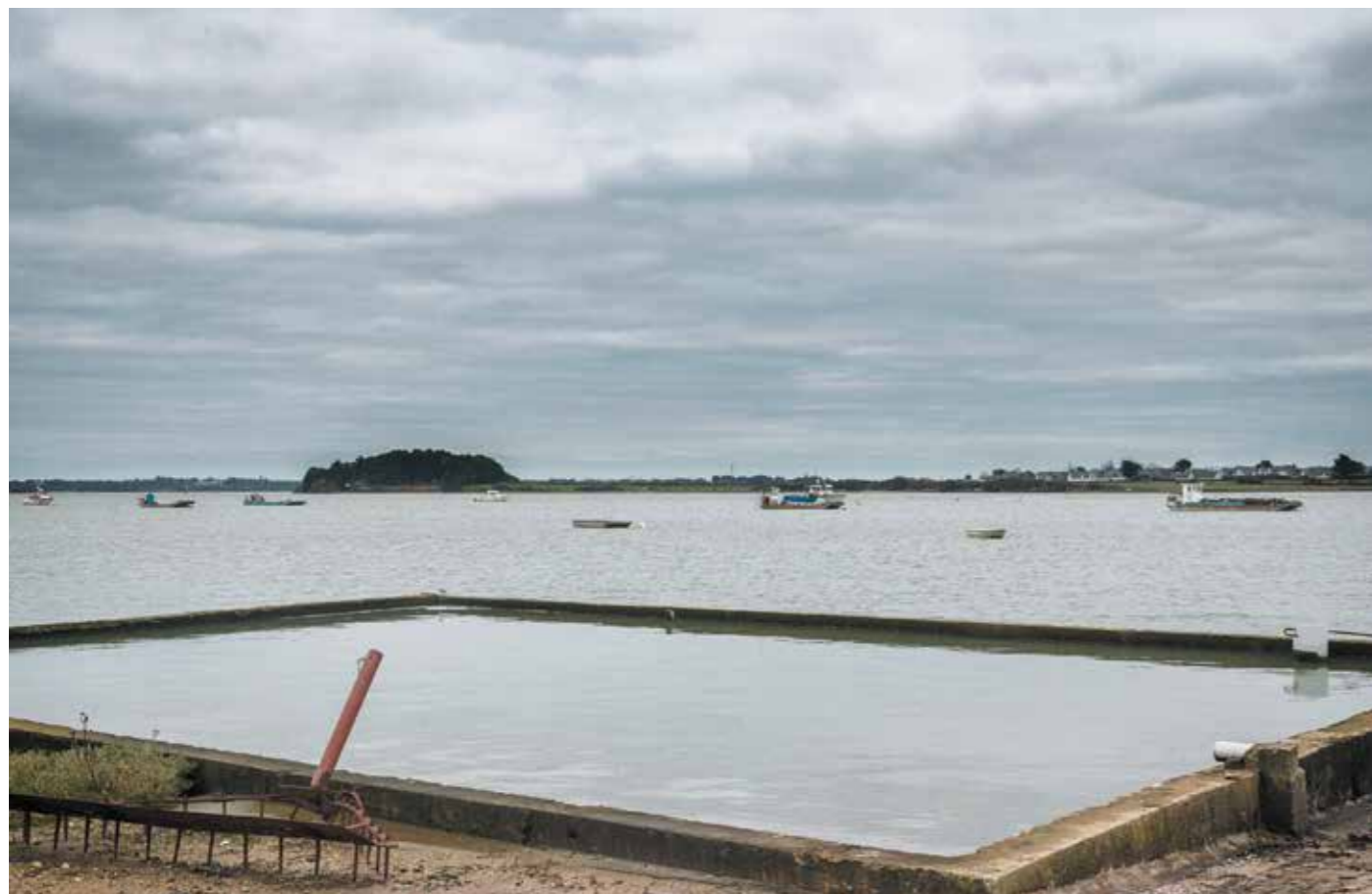
Chantier Le Joubiou, rive de Pencadenic
